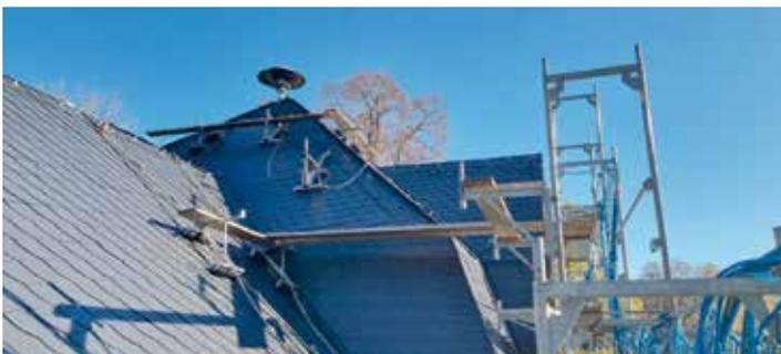
Die anspruchsvolle Dachkonstruktion mit unzähligen Kehlen und Graten sowie Dachteilflächen in unterschiedlichsten Neigungen erforderten handwerkliches Geschick und kleinteiliges Können.
